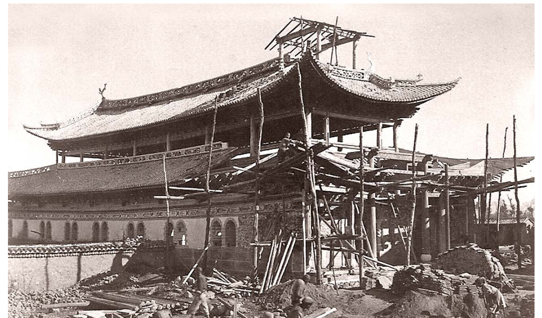
Église de Dali en construction (1928-1932)
