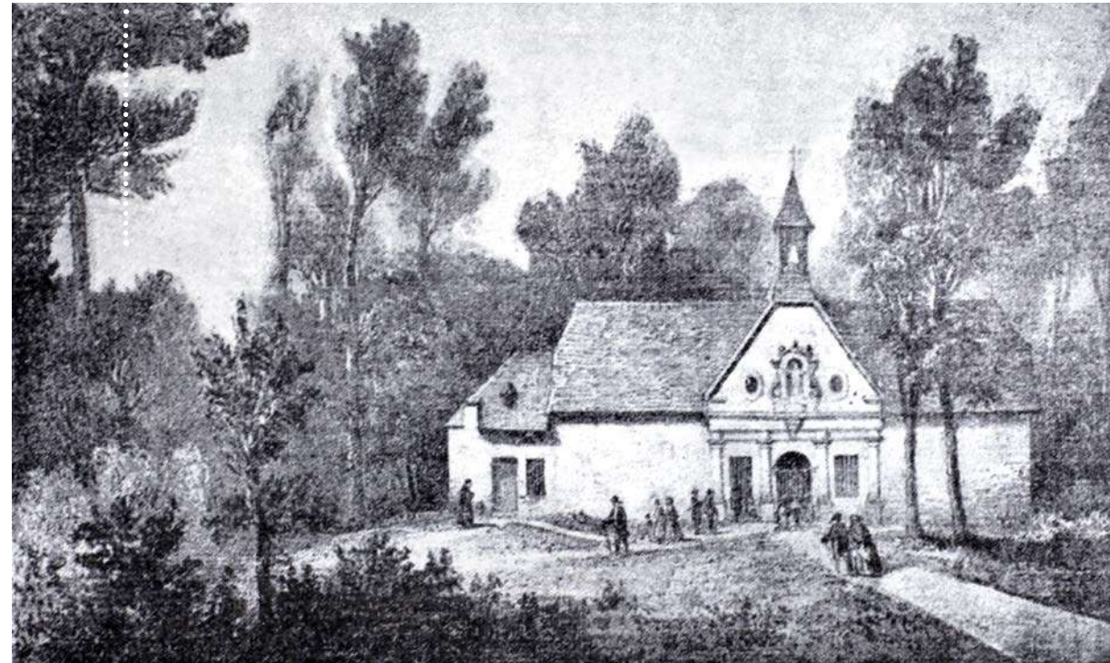
Ancienne chapelle du Saint-Sépulcre, devenue chapelle de la Résurrection, 15 e station du Calvaire
