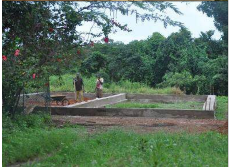
Alcune fasi della realizzazione delle fondamenta
