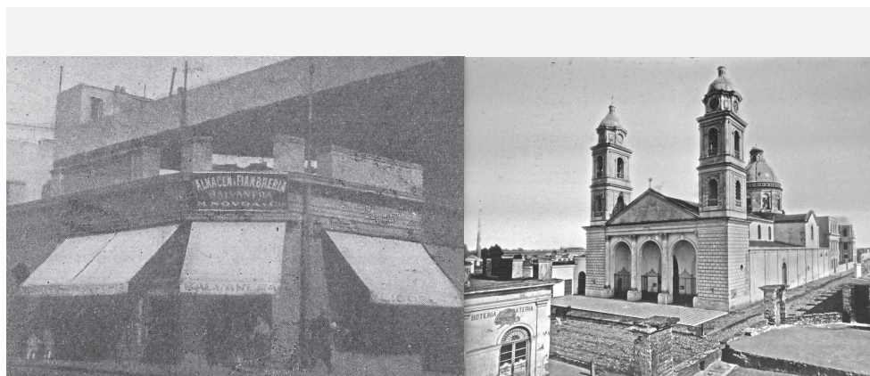
La maison de M. Rebollo, premier emplacement du Collège San José ouvert le 19 mars 1858. Comme on le voit sur la photo de gauche, tirée de Historia centenaria del Colegio San José (1858 - 1958) de B. Sarthou s.c.j., Buenos Aires 1960, la maison devint par la suite un café-charcuterie-épicerie (jusqu'à sa démolition en 1928).
