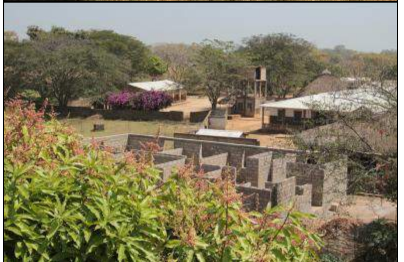
Fasi della realizzazione del blocco operatorio
