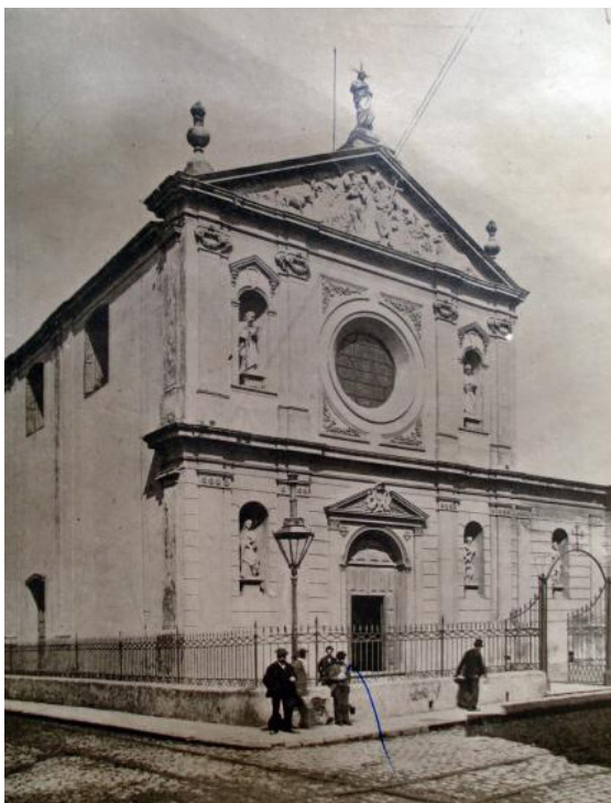
Iglesia San Juan de Buenos Aires: más arriba antes de la revisión de la fachada y tal como la conoció el P. Sardoy scj; al lado, hoy
