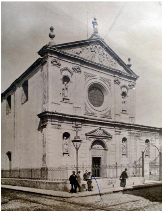
Iglesia San Juan de Buenos Aires: más arriba antes de la revisión de la fachada y tal como la conoció el P. Sardoy scj; al lado, hoy
