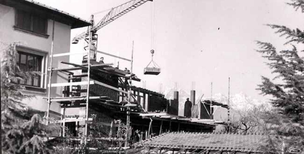
I lavori di costruzione dell'ala "moderna" del collegio Sacro Cuore, negli anni Sessanta
